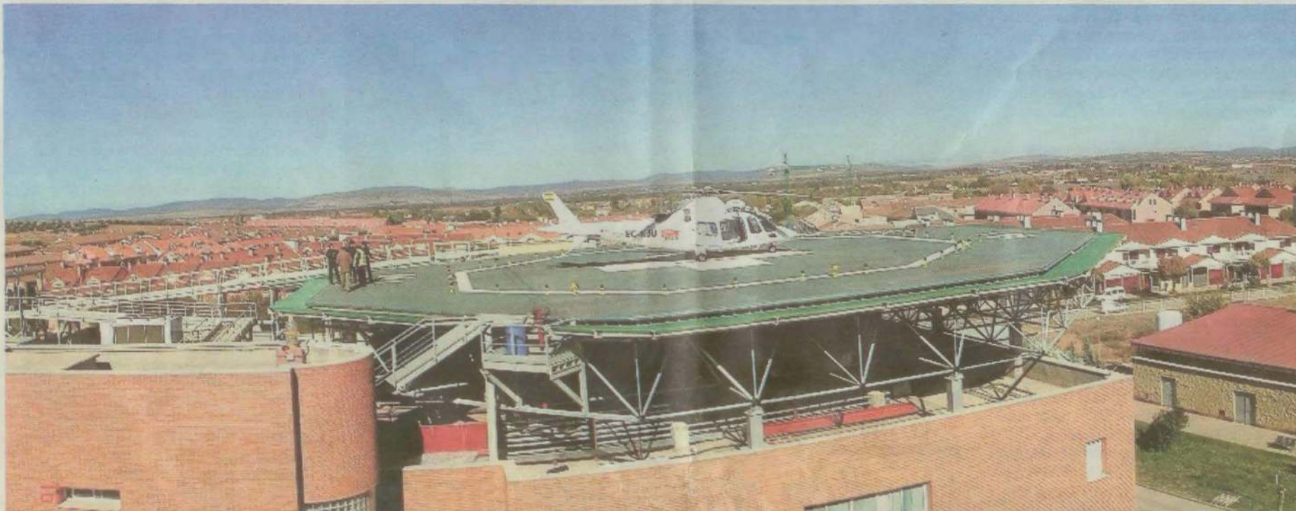
Arriba, el primer helipuerto elevado con composite construido en el Hospital de Puertollano (Ciudad Real); abajo, el equipo de Urjato trabajando en unos diseños. / EL MUNDO
